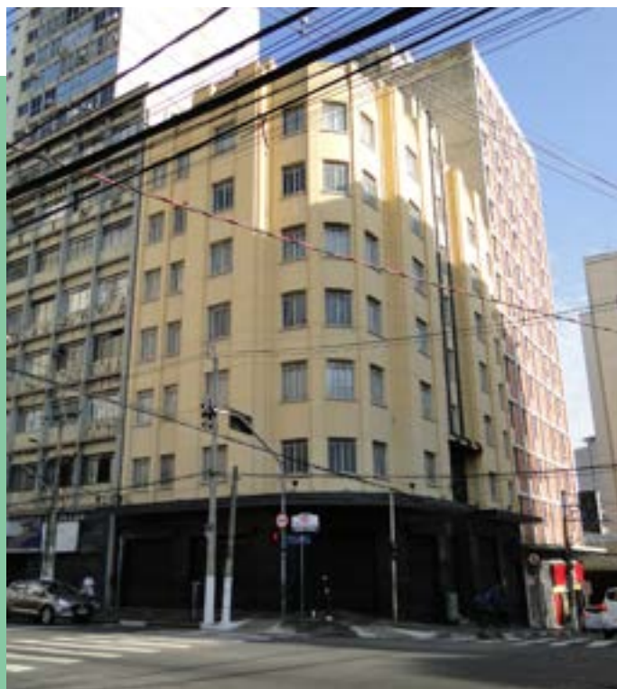
Prédio da Associação Comercial e Industrial de Campinas
