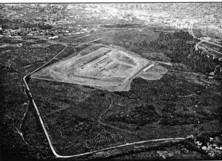
Preparação do terreno para construção do Shopping Iguatemi.
